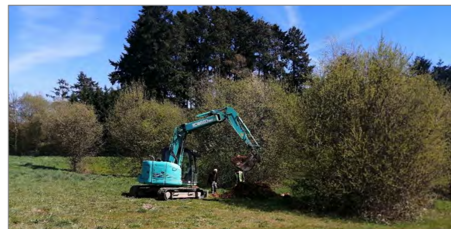
Photographie 45: Sondages géotechniques en vue d'étudier des fondations-pieux non impactantes (Source : ENCIS Environnement)
