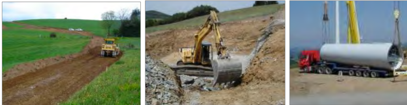
Photographie 33 : Illustration d'un chantier éolien
