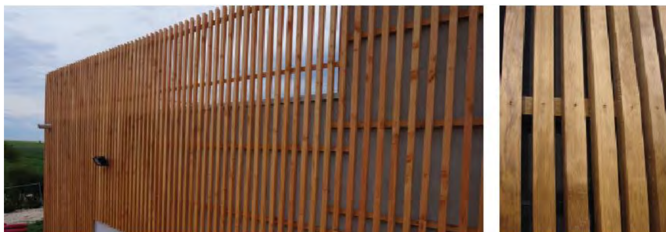
Photographie 47 : Exemple de bardage bois à claire-voie vertical garantissant l'intégration paysagère du poste de livraison tout en évitant l'installation des chiroptères attirés par le confinement (Source : ENCIS Environnement)
