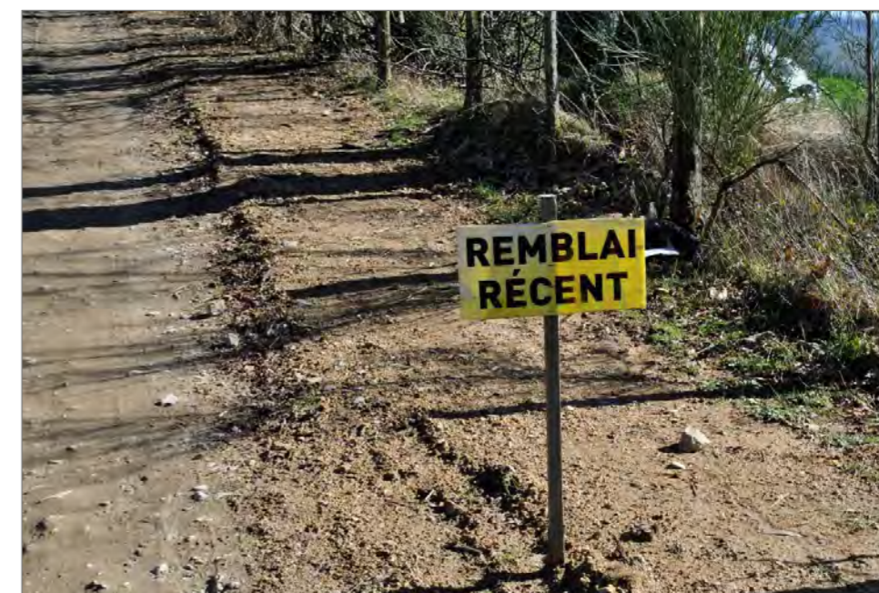
Photographie 31 : Exemple de remblai des tranchées électriques le long d'une piste (Source : ENCIS Environnement)
